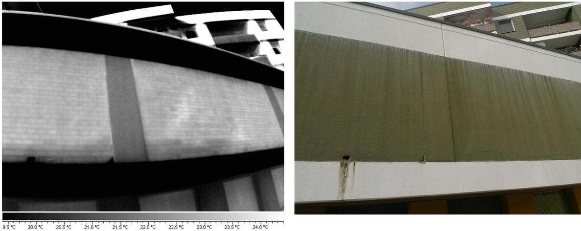
**Abb. 8.** In diesem ebenfalls durch den natürlichen Anstieg der Tagestemperatur angeregten Thermogramm zeigen sich die Unterschiede zwischen trockenem und feuchtem Mauerwerk mit höherer Wärmekapazität. Durch die sehr gleichförmige Erwärmung zeigt sich das Bauwerk als Betonskelettbau mit zweischaliger Ausmauerung, was man an der binderlosen Verfugung der Mauerwerksfläche erkennt. Hier ist Regenwasser von oben in die Trennung beider Mauer­schalen eingedrungen, ein Fall für den Dachdecker
