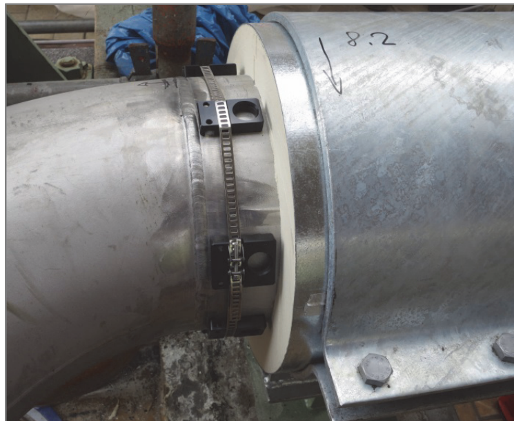
Abb. 2. Spannplatten zur Befestigung der Prüfköpfe am Rohr
