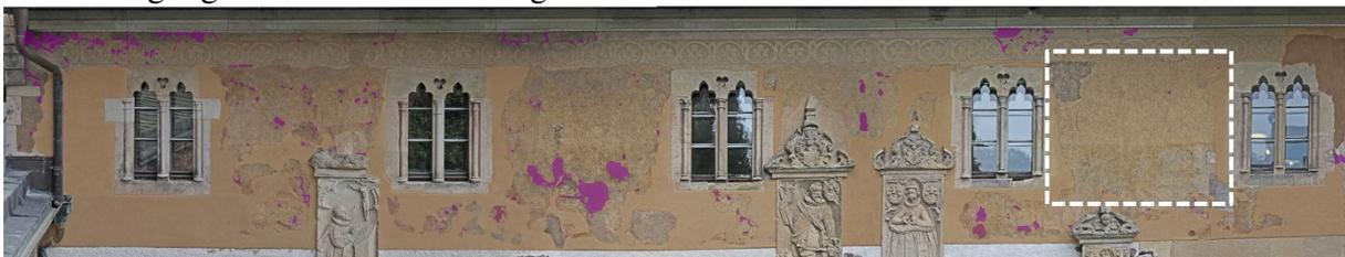
**Bild 2.** Von 2011 bis 2015 durchgeführte Verfestigungen an den Putzritzungen. Das Rechteck markiert das Zentralbild.
